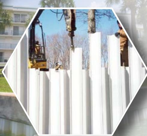
Las tablestacas sintéticas son ampliamente usadas en la construcción para aplicaciones de control de aguas como muros deflectores de agua, presas y rompeolas.
